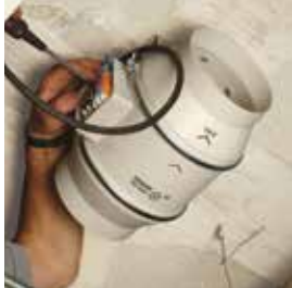
Sluit de ventilator aan.
