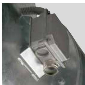
Externe klemmenkast om de aansluiting te vergemakkelijken.
