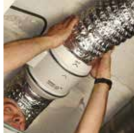
Sluit de kanalen aan.
