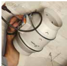
Breng de kabelaansluitingen tot stand.
