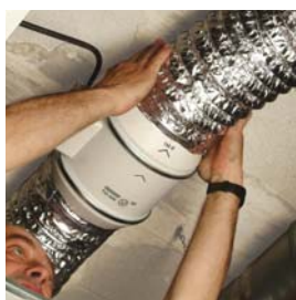
Raccorder les conduits.
