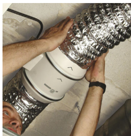
Raccorder les conduits.
