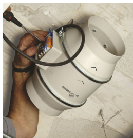
Réaliser les connexions.
