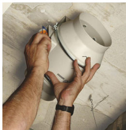
Insérer le corps moteur-hélice.
