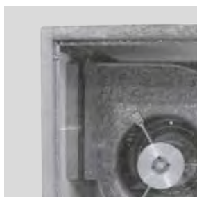
Manchette souple au refoulement Permet d'éviter la transmission du bruit et des vibrations.
