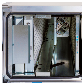
3 Fácil acceso a los filtros a través de los paneles, lateral o inferior. Dos opciones de filtración: - Versión Larga P F7 con capacidad para el montaje de dos filtros: F7 de muy baja pérdida de carga incorporado y posibilidad de montaje de un segundo filtro (suministrado como accesorio). El sistema de apriete de filtros mediante brazos articulados garantiza una excelente estanqueidad del conjunto de filtros. - Versión corta M5 con capacidad para el montaje de un único filtro M5 montado mediante sistema de guías sin dispositivos de apriete del filtro.
