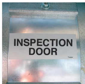
Puerta de inspección en la voluta del ventilador para facilitar la limpieza
