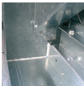
Caja estanca que evita la salida de condensados
