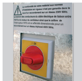
Interruptor paro/marcha montado y cableado
