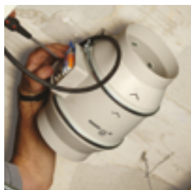
Breng de kabelaan sluitingen tot stand.
