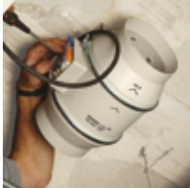
Sluit de ventilator aan.
