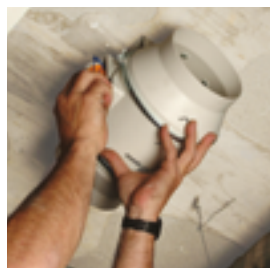
Plaats de waaier- en motorconstructie.
